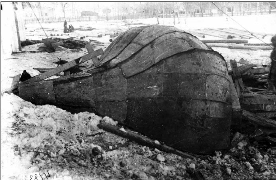
Купол разрушенного Троицкого кафедрального собора. 1929 год. Фотоархив ГААО. № 3-337
